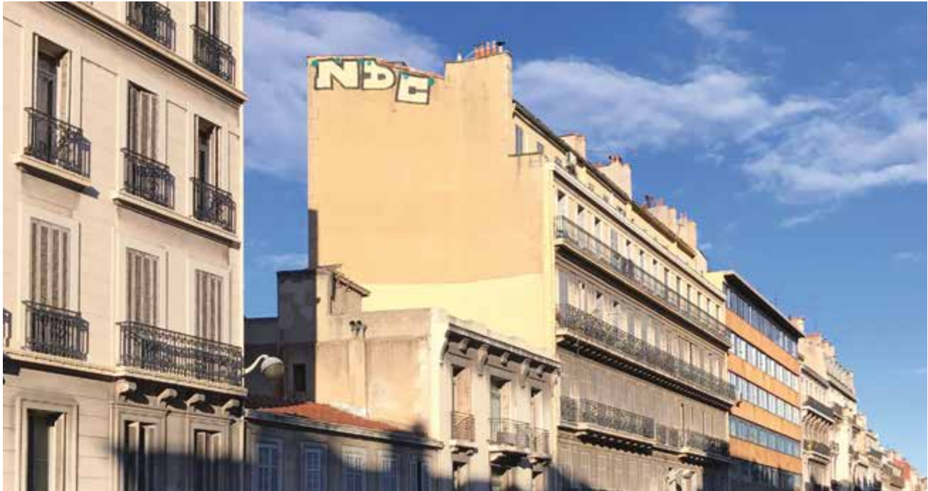
Der Schriftzug «NDC» entstand in der Nacht bevor das Baugerüst entfernt wurde, das der Fassadensanierung gedient hatte.
